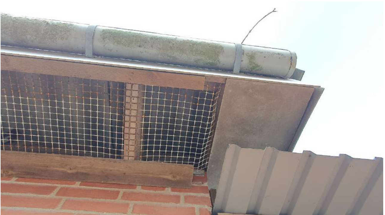
Figur 20: Gitter under udhæng. Kvadraterne er større end en dværgflagermus.
