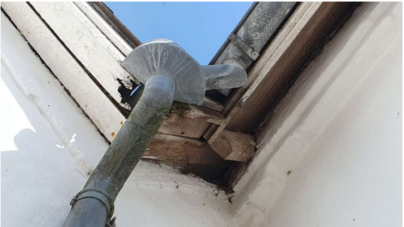
Figur 7: Råddent træværk hvor to tagudhæng mødes.
