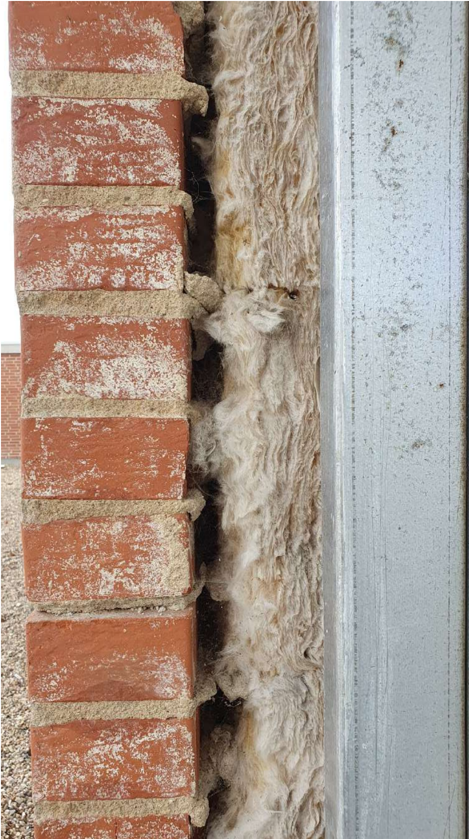
Figur 25: Her kan man vurdere størrelsen på hullet mellem ydre mur og indre væg.
