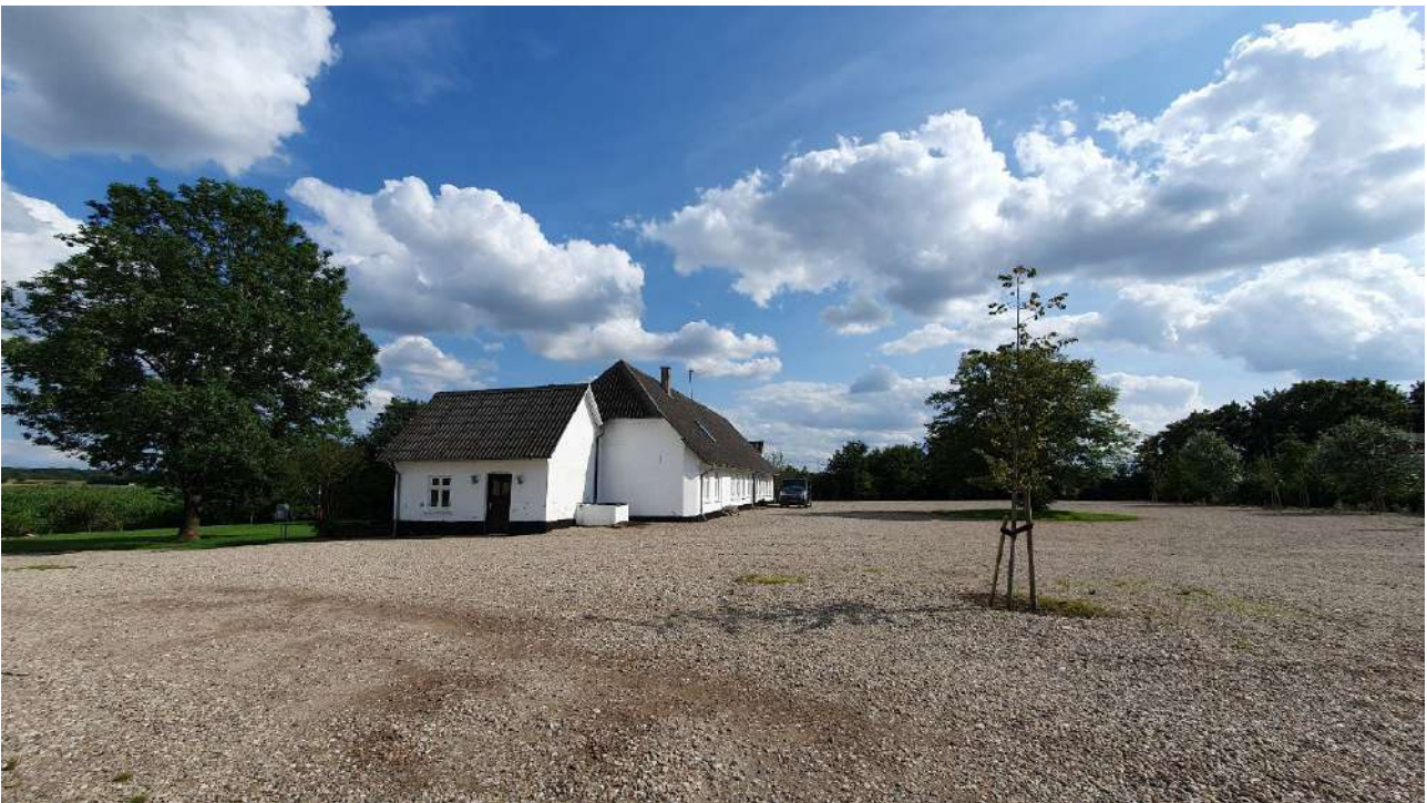
Figur 3: Stuehuset set fra gårdspladsen.
